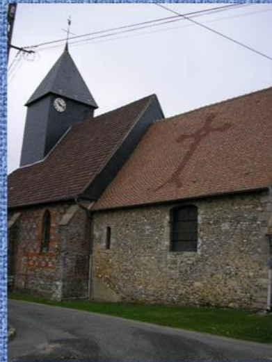
Croix sur la toiture de l'église
